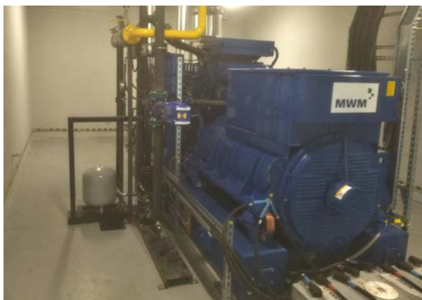
Dozamel S.A. we Wrocławiu kogeneracja o mocy cieplnej 1700 kW i elektrycznej 1600 kW
