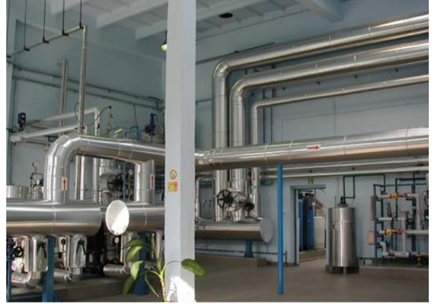
Dozamel S.A. we Wrocławiu kotłownia wodna wysokotemperaturowa o mocy 24 MW
