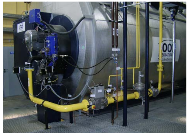
Zakłady Mięsne Morliny kotłownia parowa o wydajności 36 t/h
