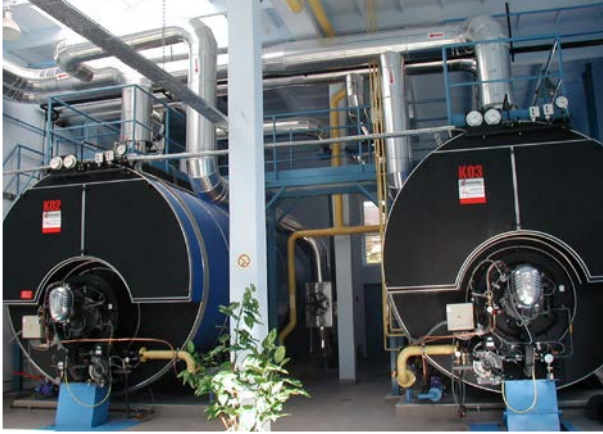
Dozamel S.A. we Wrocławiu kotłownia wodna wysokotemperaturowa o mocy 24 MW
