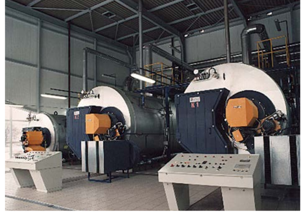
Zakłady Mięsne Morliny kotłownia parowa o wydajności 36 t/h
